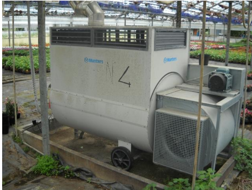
Fig. 1: Caldaia a terra
