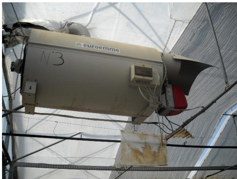
Fig. 2: Caldaia sospesa
